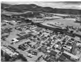
※写真は、2018年7月、日本豪雨による山梨県飯倉町の被災状況
